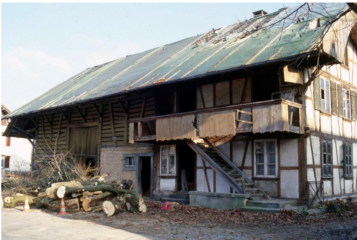
Mittelstrasse 10 – Kurz vor Abbruch – 2001 Januar
