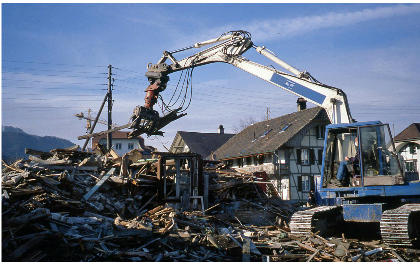
Mittelstrasse 10 – Abbruch – 2001 Januar
