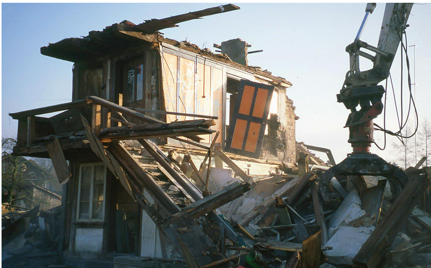
Mittelstrasse 10 –Abbruch – 2001 Januar
